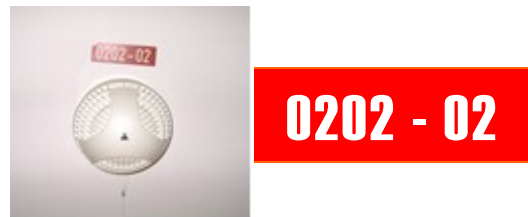
Abbildung 7 - Beispiel Melderkennzeichnung
